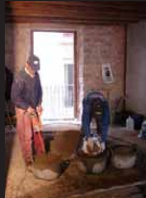
3-06_8_preparacion hormigon arlita
